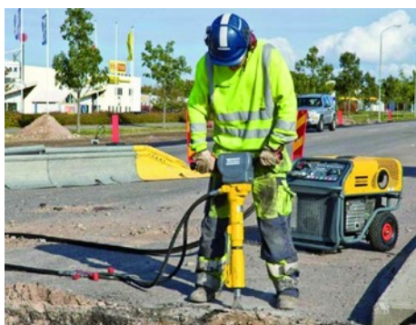
Taladro de concreto (Sonido desagradable)
